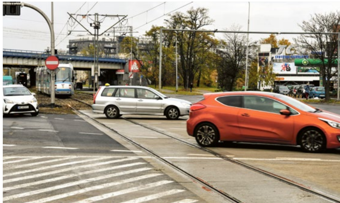
Jednym z planowanych do remontu odcinków jest torowisko od ul. Zachodniej do ul. Niedźwiedziej
